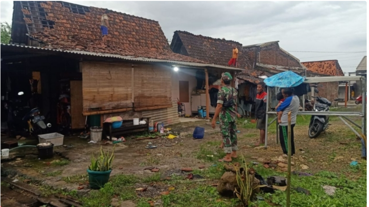
Babinsa Koramil 13/Karangawen Cek Rumah Rusak Akibat Puting Beliung
