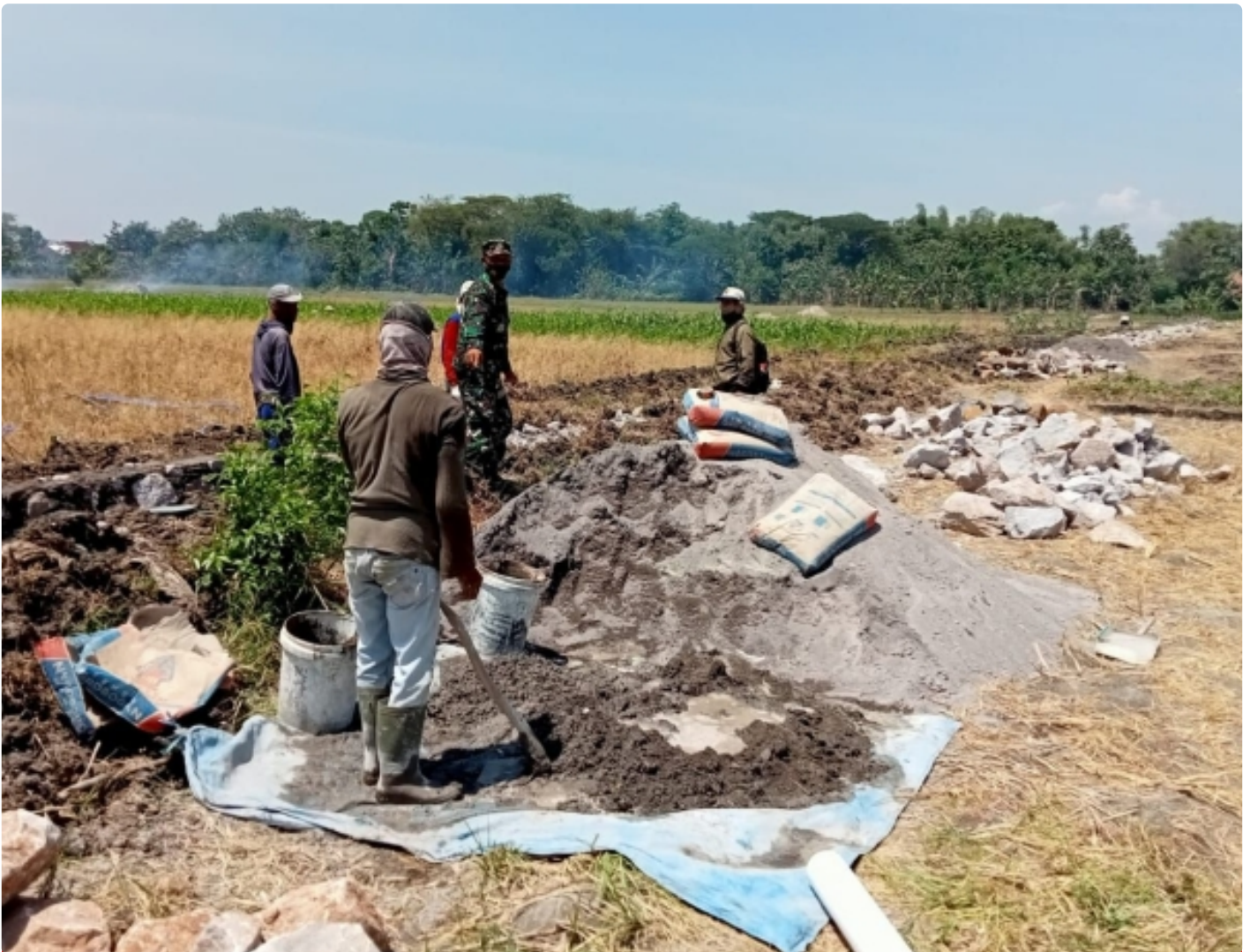
Giat Babinsa dan Kades Temuroso Pantau Pembangunan Irigasi Persawahan
