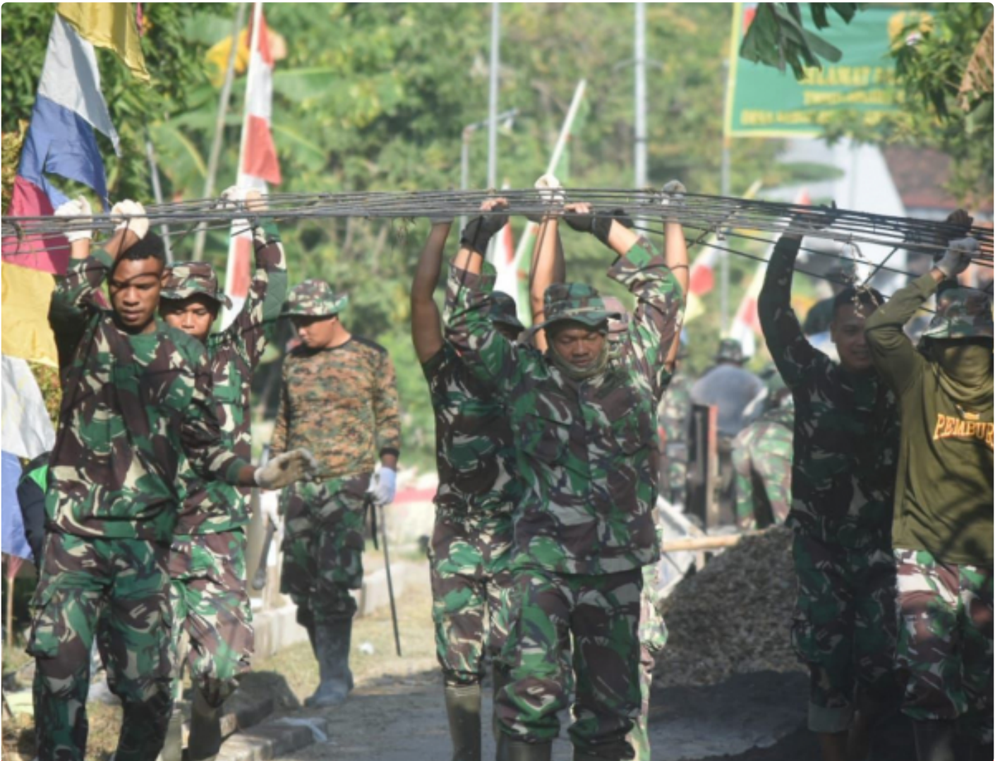
TMMD Reguler ke-114 Kodim 0716/Demak Sasaran Pengecoran Jalan Desa Kebonagung, Demak.
