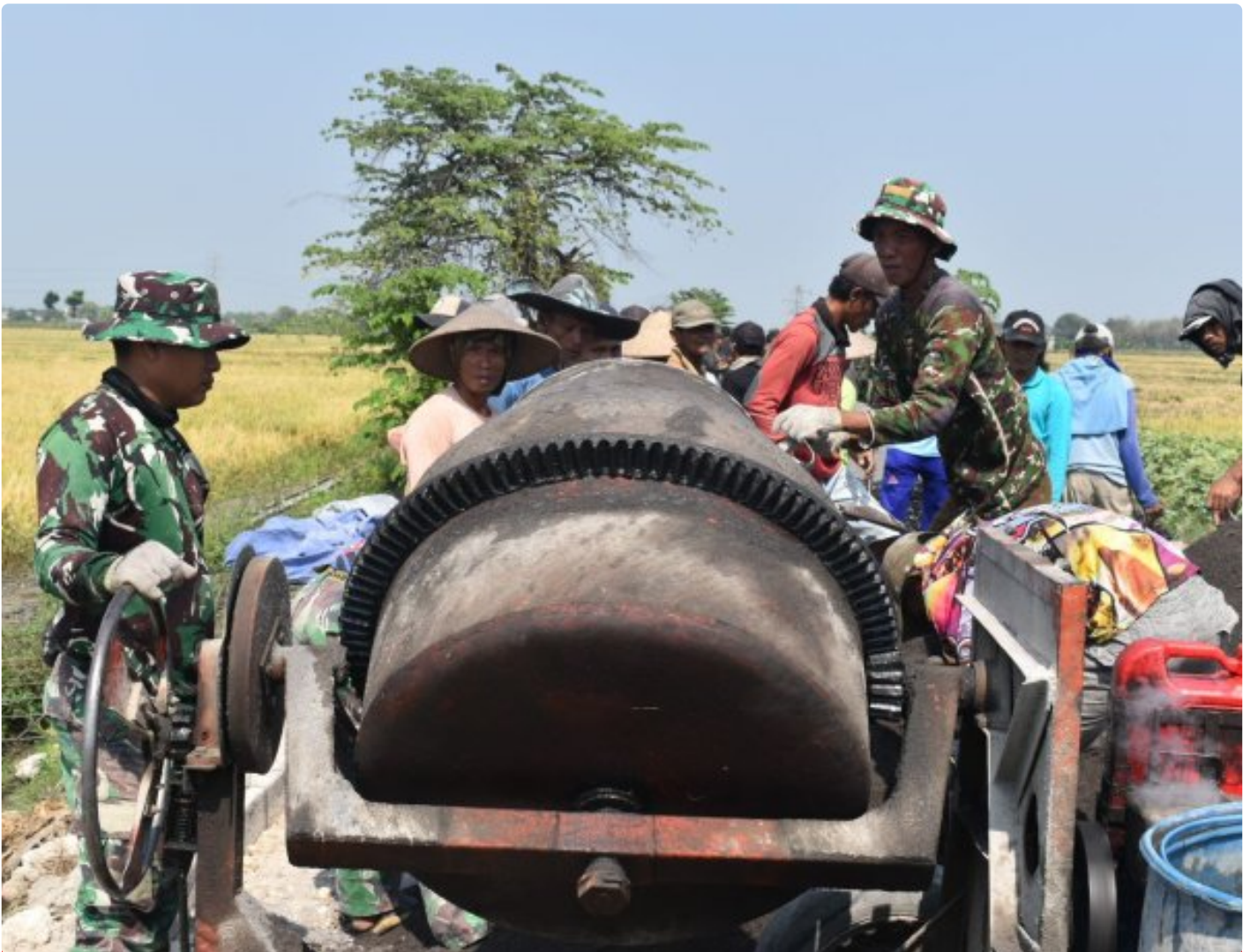
Peran Serta Warga Desa Ngaluran Bantu Pengecoran Jalan TMMD
